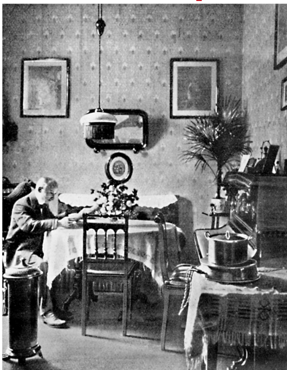
Einblick in die elektrifizierte Wohnung Paul Rosinys in der Steinstraße um 1911 mit Licht, Heizkessel und Kochplatte.
