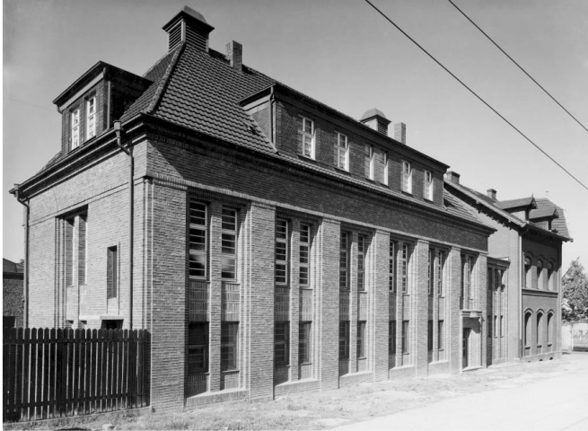
Das Umformerwerk an der Obergasse um 1930. Rechts zu erkennen der Altbau, in dem sich bis 1906 das Elektrizitätswerk Hochstrate & Böttcher befunden hat.
